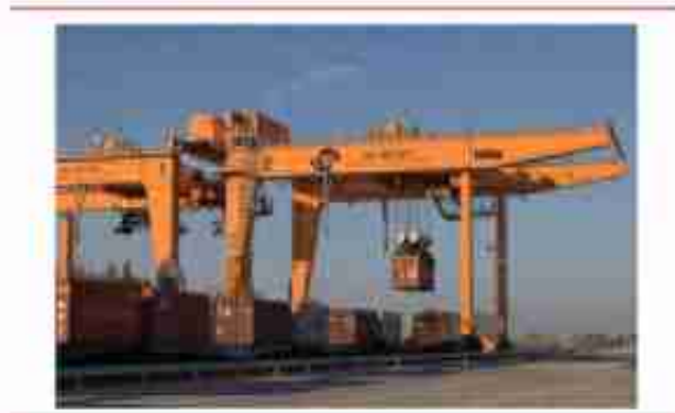
图24: 匈牙利欧洲首个5G专用铁路港口
